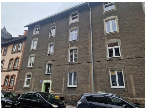
Zdjęcie 3 Elewacja północna
