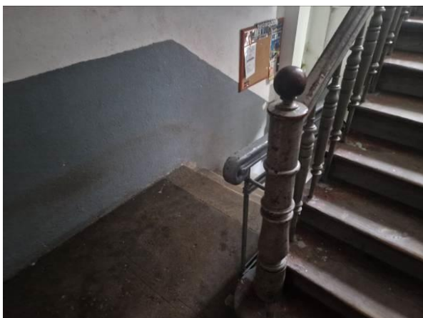
Zdjęcie 5 Klatka schodowa
