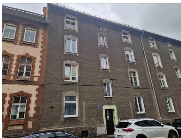
Zdjęcie 4 Elewacja północna
